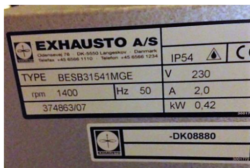
Typeskilt fra udsugningsaggregat
