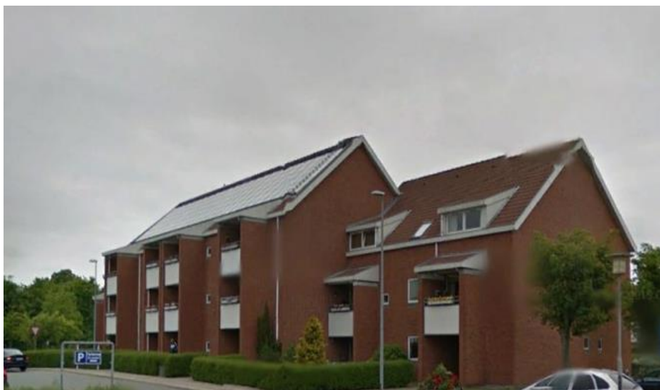
Billede af Afd. 17 solfangeranlæg
