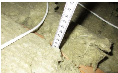
Tjekmål af isolering på vandret loft
