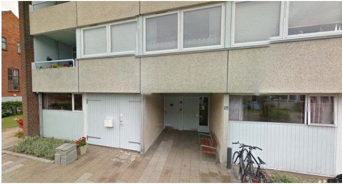
Vinduerne i forbindelse med altaner, opbevaringsarealer og indgangspartier har 2-lags termoruder
