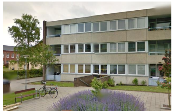
Vinduerne langs facaderne er nyligt skiftede og har 2-lags energiruder
