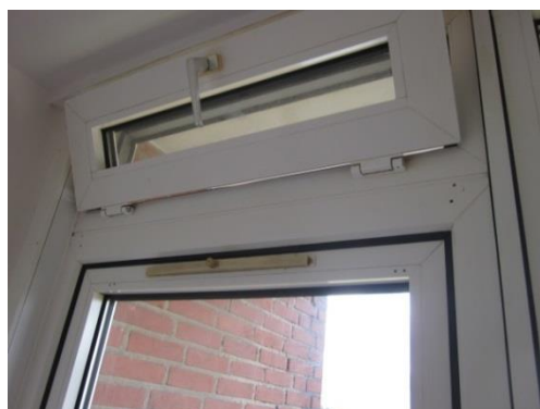
Ventilationsspalte øverst i nogle af vinduerne
