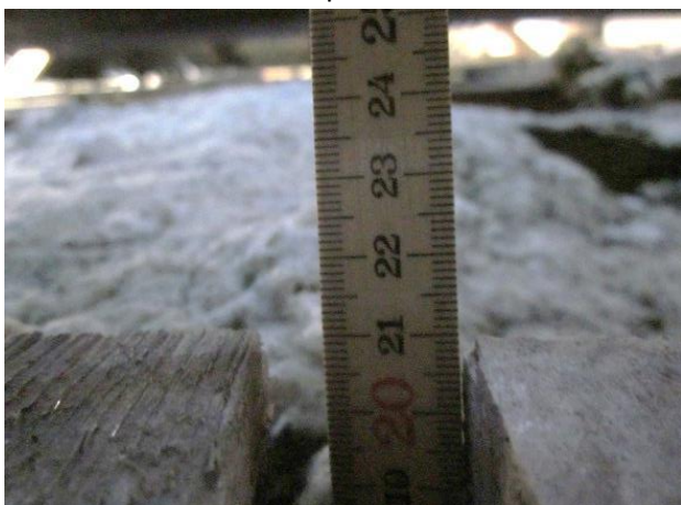
Tjekmål af isolering på loftet
